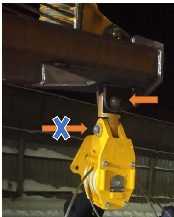
Рисунок 3.103. Демонтаж подвесного блока
